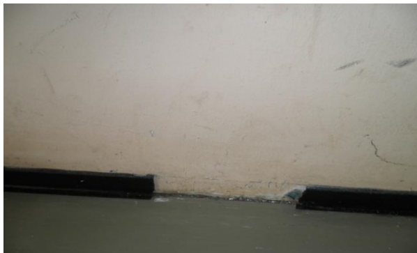
Abb. 20 Fußleiste (Gebäude Kolpingstr.)
