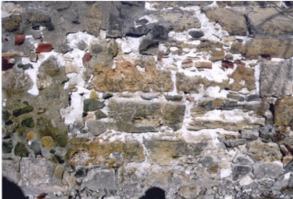
Abbildung A 2: Johannes-Servatius in Pöhlde, Südseite, Bereich B der Probenahme (rechts)
