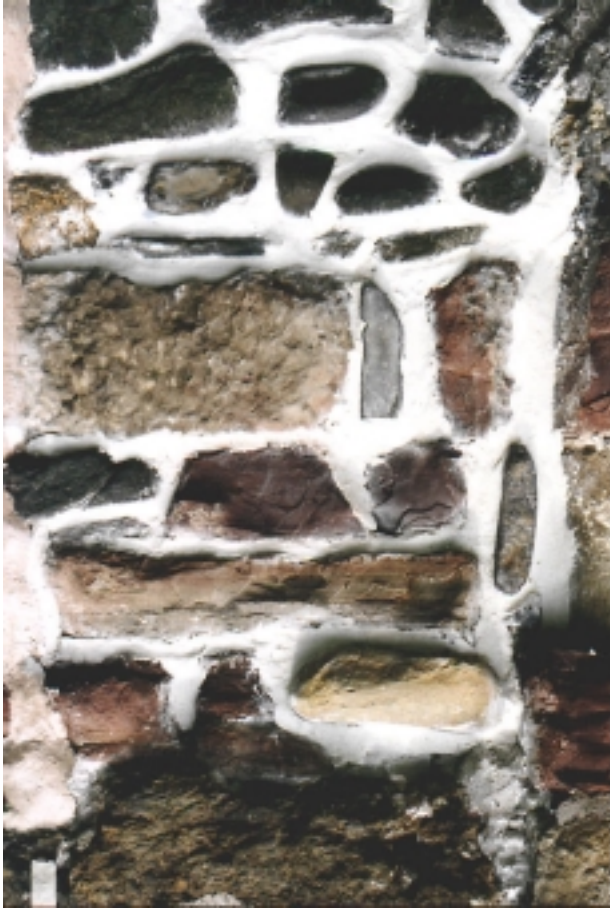
Abbildung 71: Teilfläche B – applizierter „weißer“ Mörtel, am Tag der Verfugung
