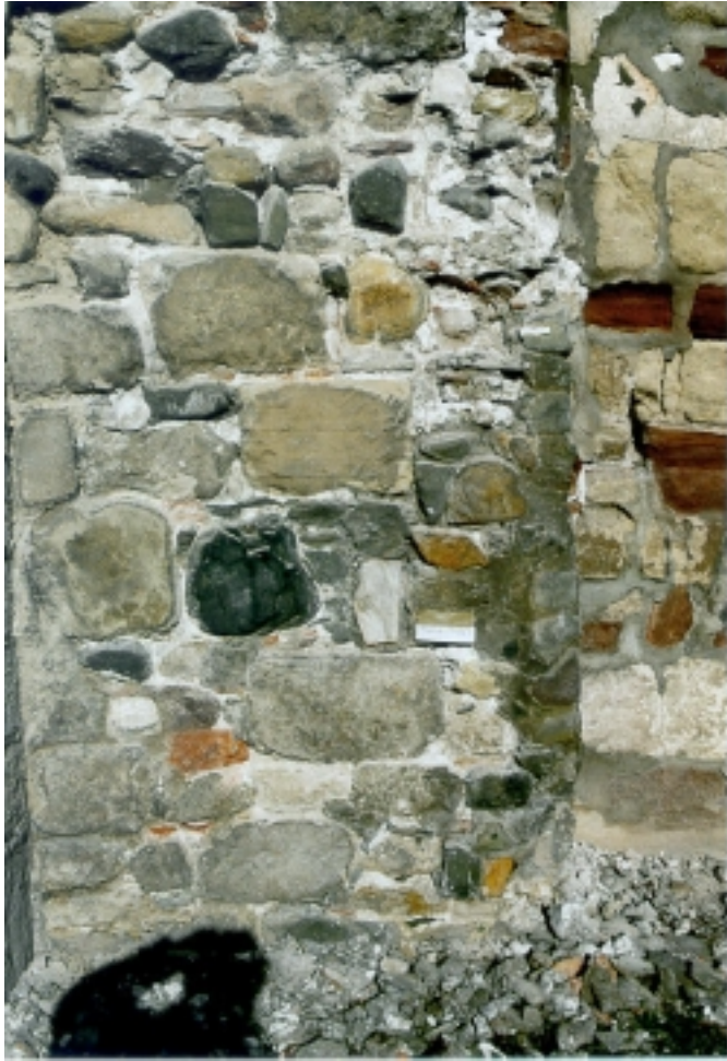
Abbildung A 3: Johannes-Servatius in Pöhlde, Südseite, Bereich A der Probenahme (links)
