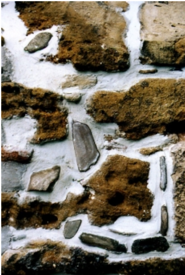
Abbildung 70: Teilfläche B – applizierter „grauer“ Mörtel, am Tag der Verfugung
