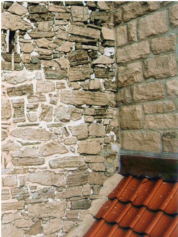
Abbildung 73: Fläche nach Applikation des weißen Mörtels – am Tag der Verfugung
