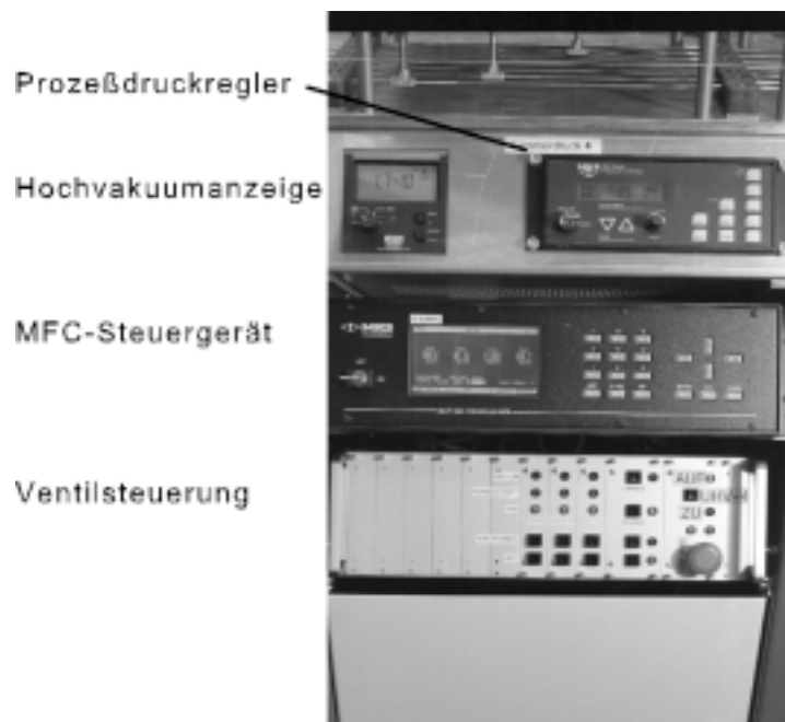
Abb. 9.3.2: 19“-Einschübe zur Prozeßsteuerung der Bandanlage
