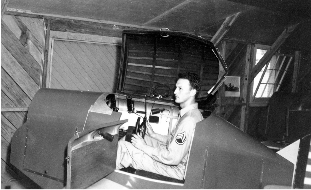
Abb. 2: Früher Flugsimulator (1943), nach Ed Link als »Link Trainer« benannt
