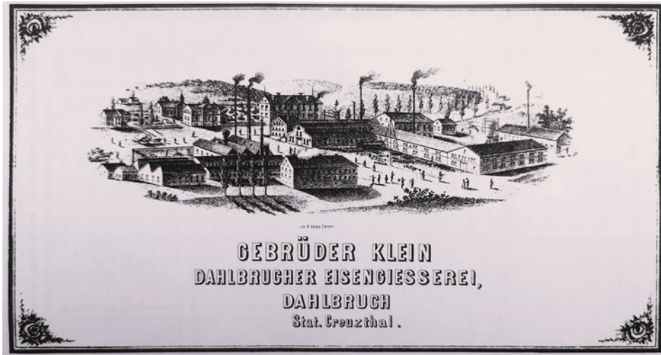
Abb. 10: Eisengießerei der Gebrüder Klein, Lithographie um 1875. Im Hintergrund das Alte Schulhaus hinter den Villen der Familie Klein (links oben). Erkennbar ist die Ausrichtung des Schulhauses Richtung Wittgensteiner Straße und Eisengießerei.
