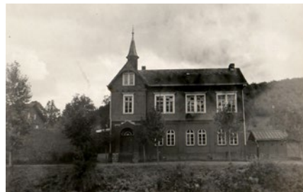
Abb. 12: Allenbacher Schule mit Aufstockung, Foto o. D. Ähnlich wie die Dahlbrucher Schule wurde das Gebäude zweimal erweitert: 1886 durch die Aufstockung eines zweiten Klassenraums und 1953 durch den Anschluss eines zweistöckigen Erweiterungsfüßels.
