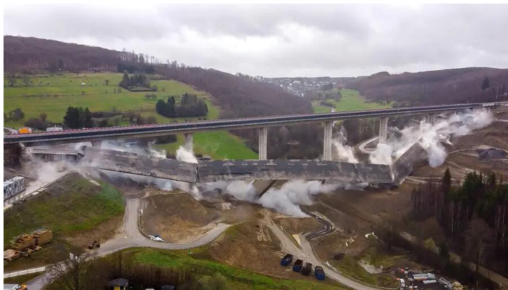
Figure 1: Talbrücke Eisern, Quelle: Siegener Zeitung
