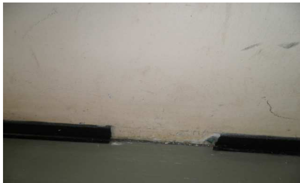
Abb. 32 Fußleiste (Gebäude Kolpingstr.)
